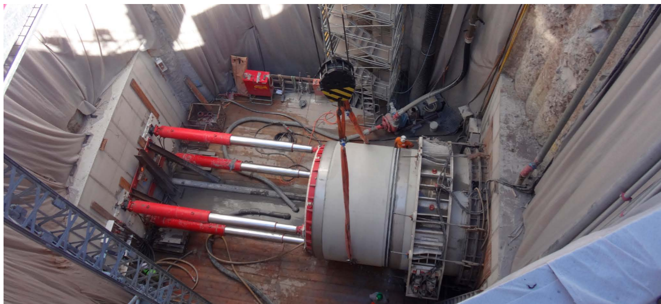
© HABA-Beton Rohrvortrieb in Dresden - Stadtbahn Mediendüker Nossener Brücke
